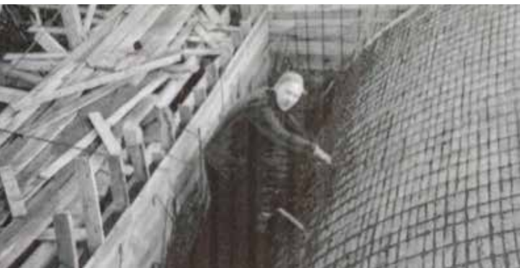
▲ André Bentzen murer med jobbestein mot forskaling. Han er akkurat ferdig med læretiden. Derfor tilskuere. Han får lov til å jobbe selvstendig, greier han det? Til venstre i bildet står hans læremester. Vi kalte ham for «kuppert» etter skøyteløperen med samme navn. De to andre står og gliser av André. ◀ Armeringen av støpen over rundbuen. Under armeringen er det ferdig slemmet eller støpt. Bak personen i bildet er det satt opp forskaling.
