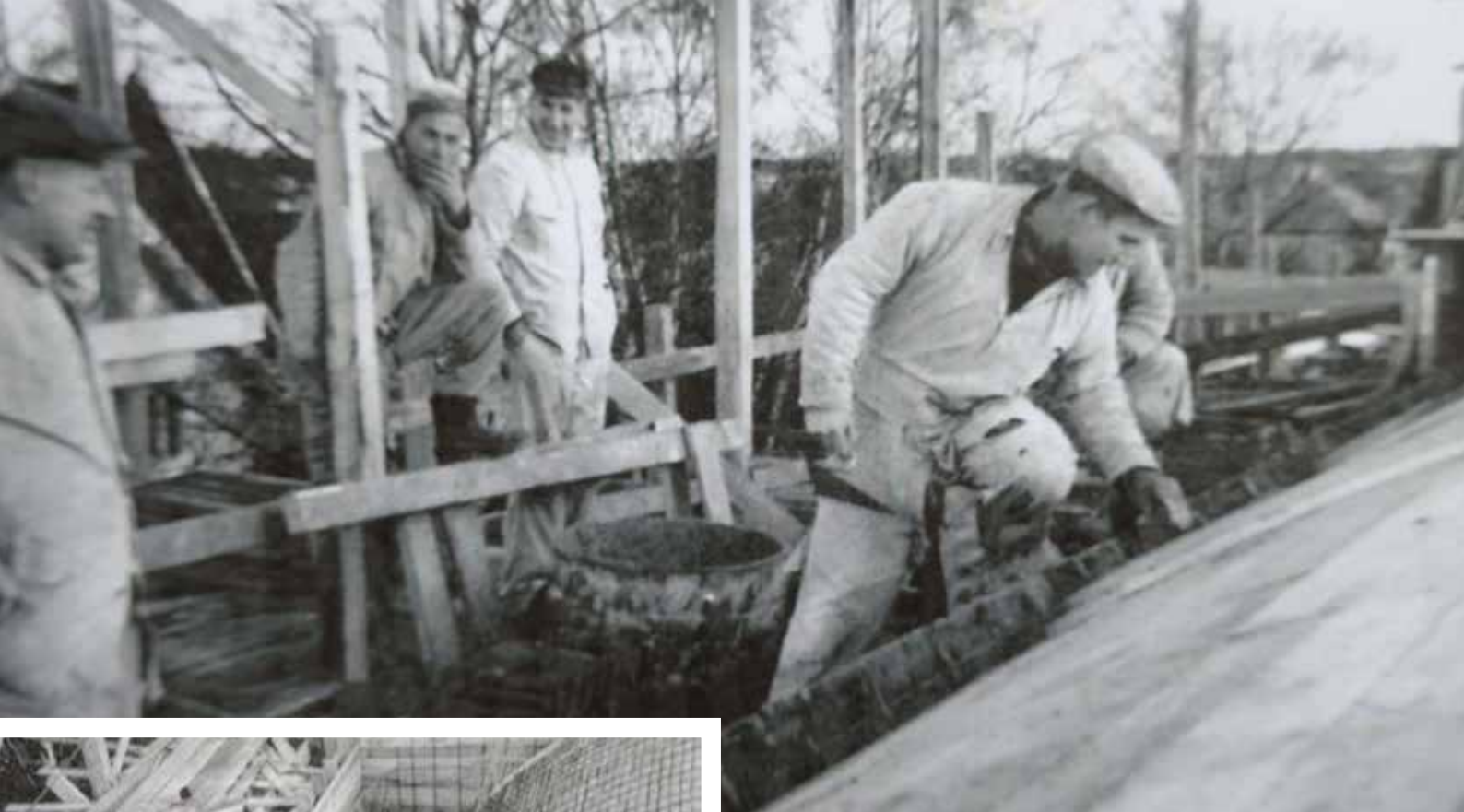
▲ André Bentzen murer med jobbestein mot forskaling. Han er akkurat ferdig med læretiden. Derfor tilskuere. Han får lov til å jobbe selvstendig, greier han det? Til venstre i bildet står hans læremester. Vi kalte ham for «kuppert» etter skøyteløperen med samme navn. De to andre står og gliser av André. ◀ Armeringen av støpen over rundbuen. Under armeringen er det ferdig slemmet eller støpt. Bak personen i bildet er det satt opp forskaling.
